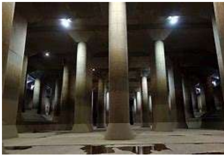
首都圏外郭放水路(イメージ)
